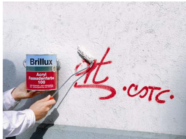
Schadstelle (evtl. nach partieller Putzreparatur) wird mit geringer Farbmenge überstrichen
